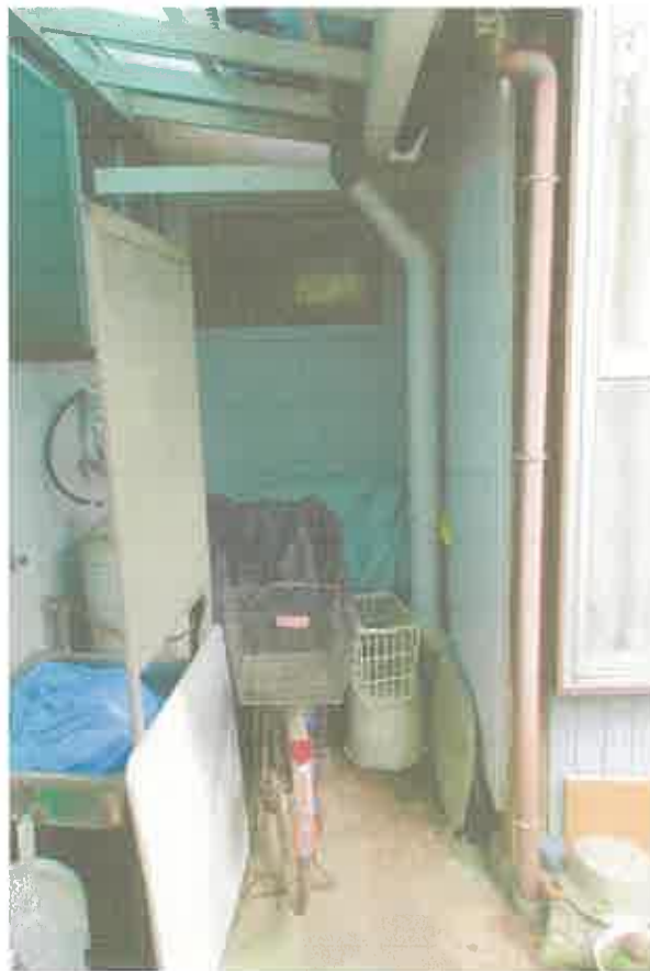
⑩ 物件11と物件12を繋ぐ廊下部分の外観
