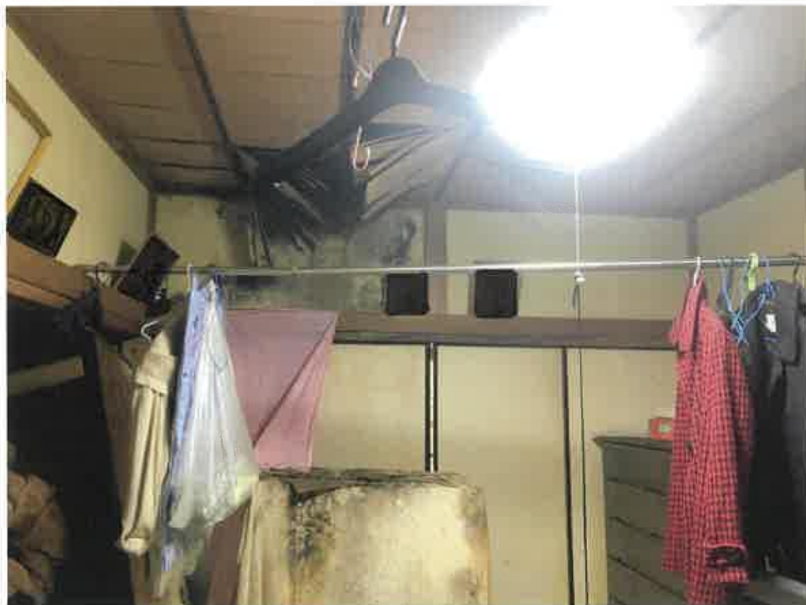
⑧雨漏りの損傷
