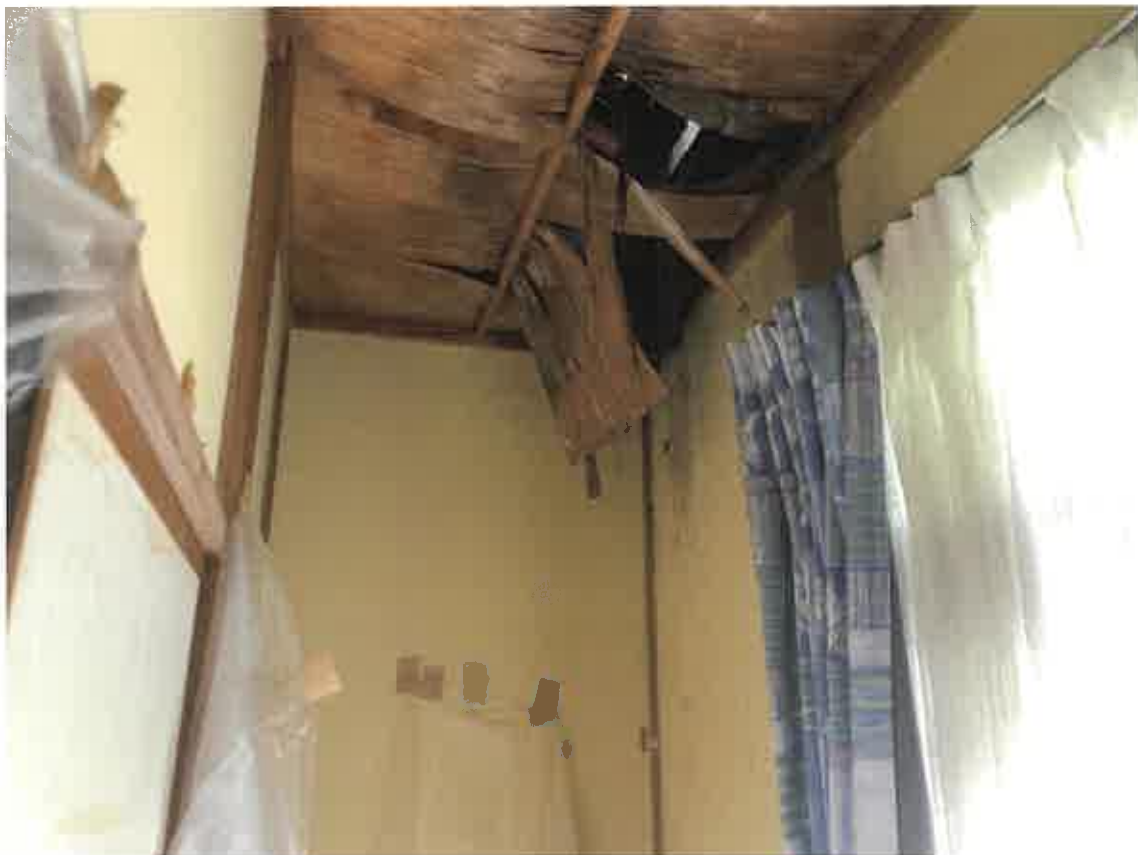
⑧雨漏りの損傷
