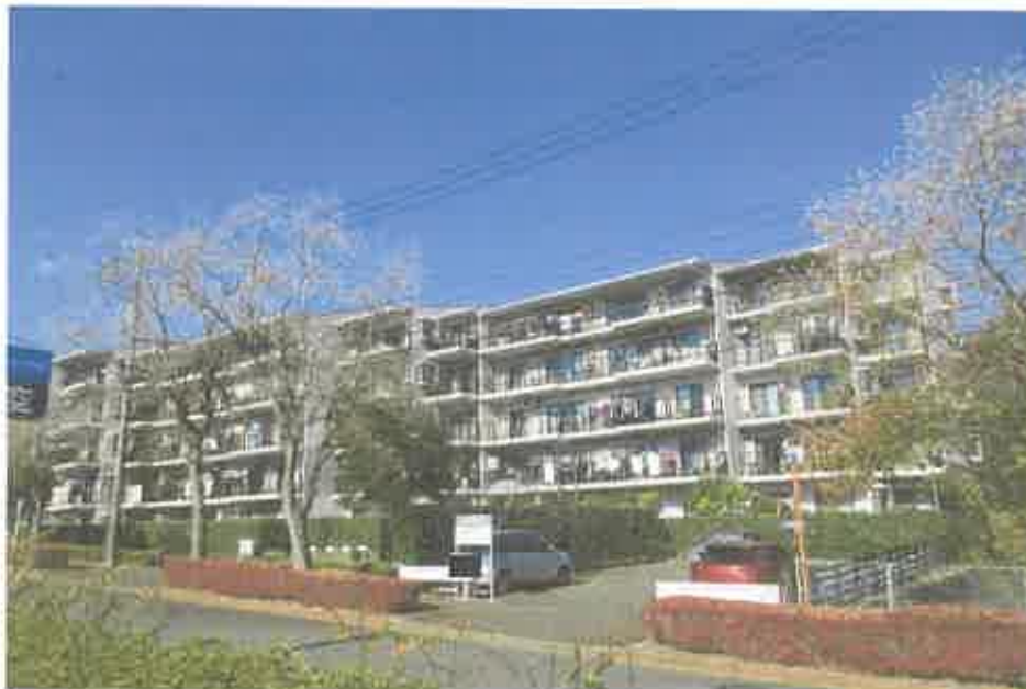
① 物件 1 を含む一棟の建物
