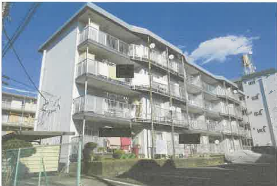
① 物件1を含む一棟の建物
