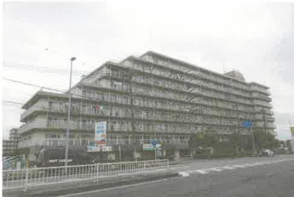
① 物件1を含む一棟の建物
