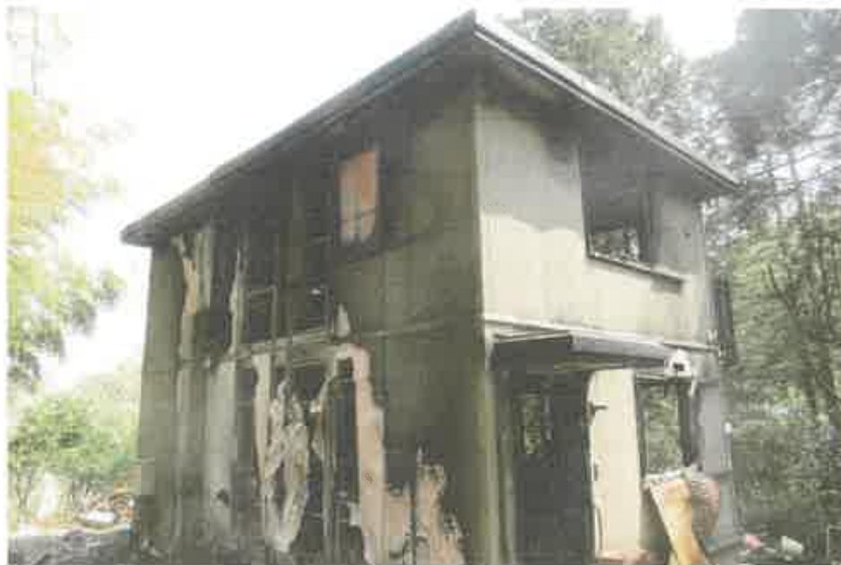
① 物件2 建物の状況
