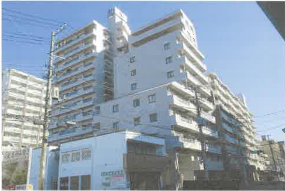
① 物件1を含む一棟の建物
