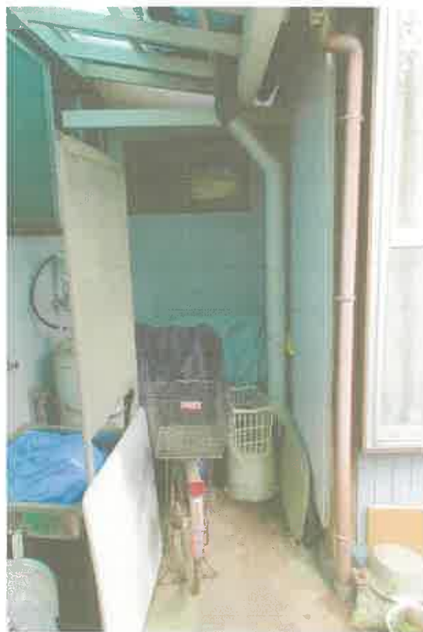
⑩ 物件１１と物件１２を繋ぐ廊下部分の外観
