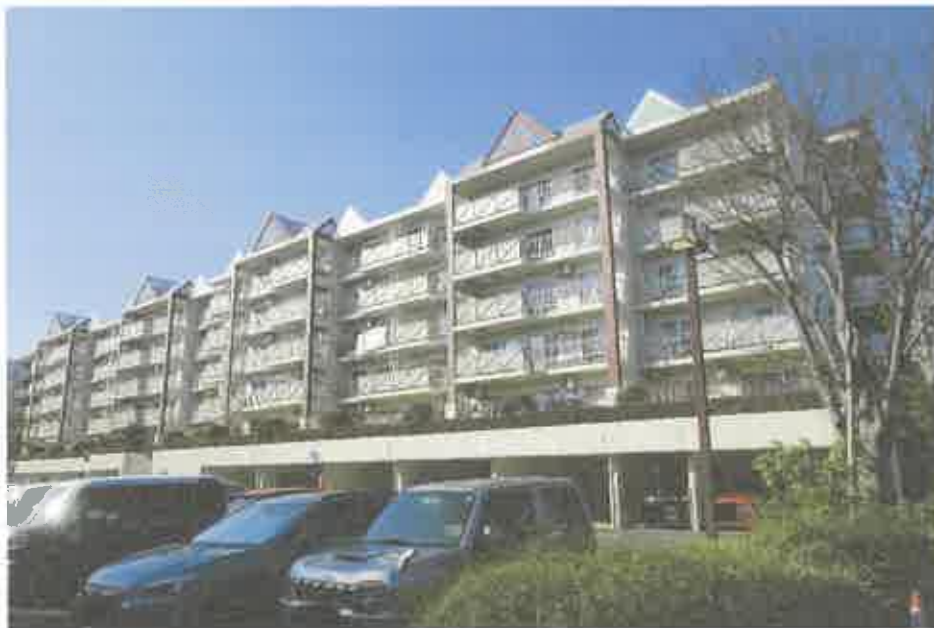
① 物件1を含む一棟の建物
