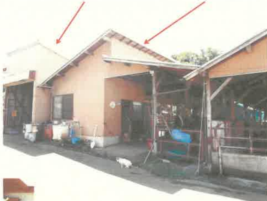
⑥ 物件 6 3 の附属建物 ( 5 ) 同建物 ( 4 )
