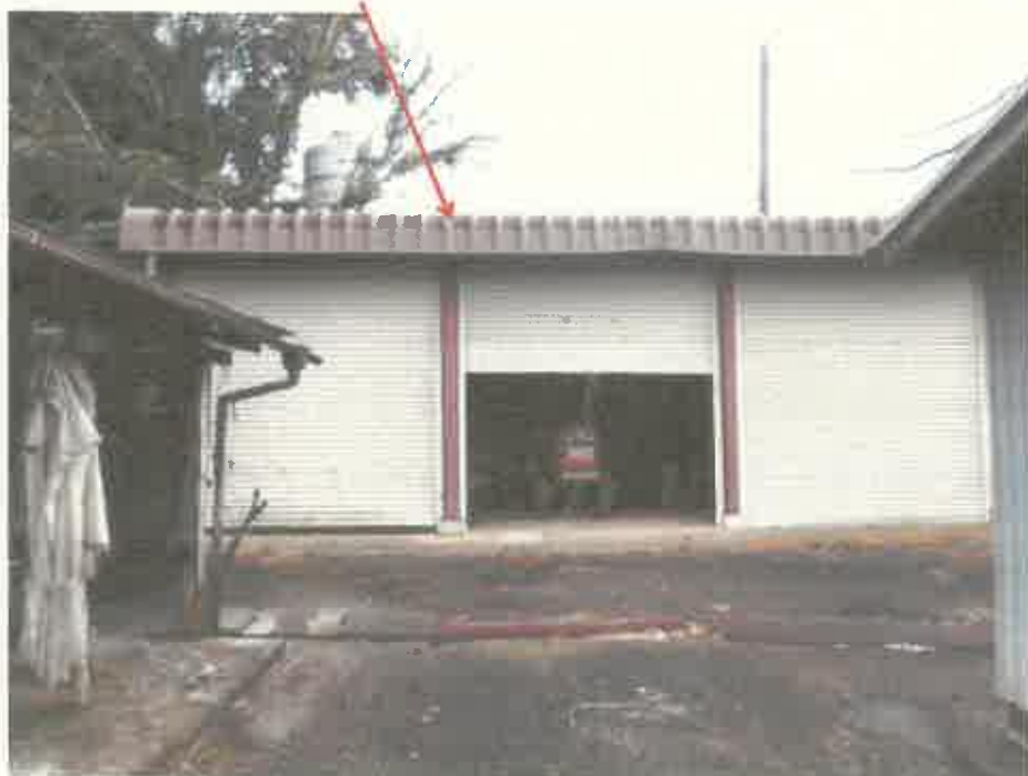
物件 6 3 の附属建物 ( 1 )
