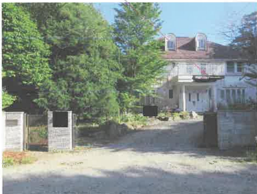
① バルコニーの北西側は木材がむき出しで、損傷が激しい
