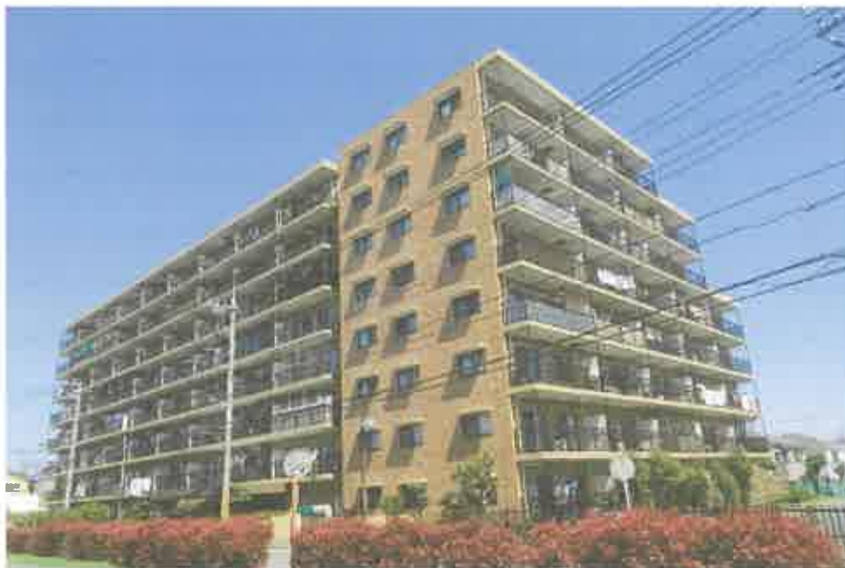
① 物件1を含む一棟の建物
