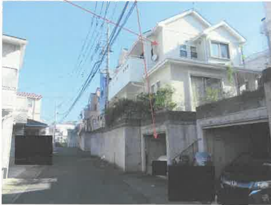
① 本件物件 / 未登記附属建物（車庫）
