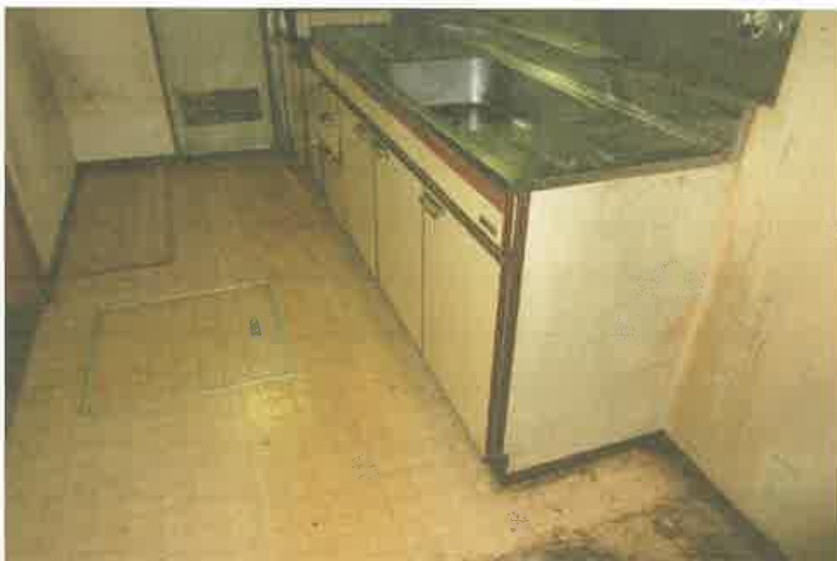
④ 壁及び床の汚損
