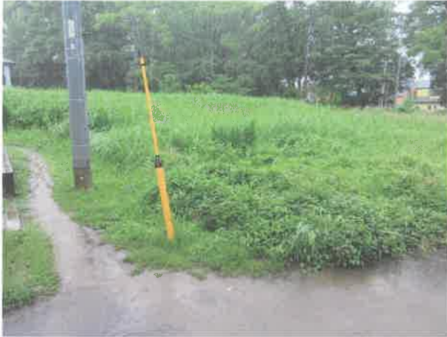
③ 物件3 電柱が土地上に存在
