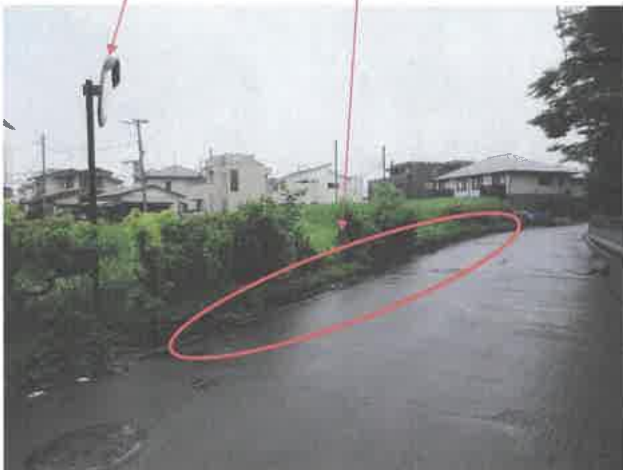
④ カーブミラーが土地上に一本存在した。 道路に沿って低いコンクリートの擁壁が存在した。
