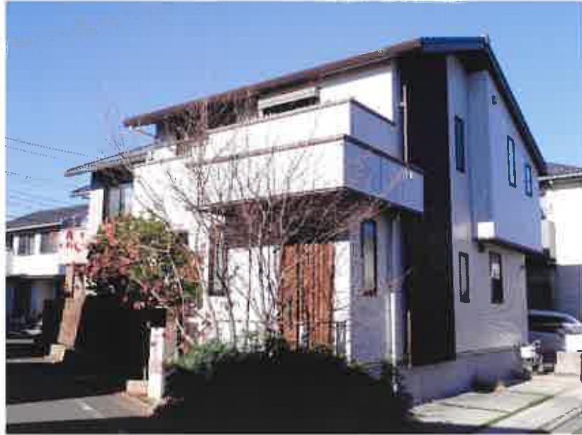
① 目的物件南東側の状況
