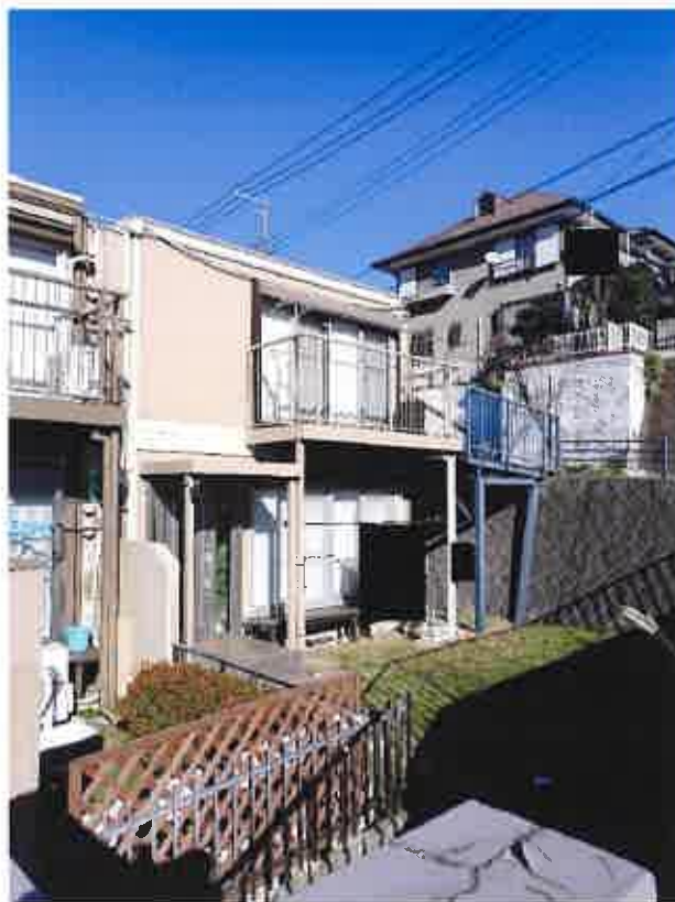
① 目的物件南西側の状況
