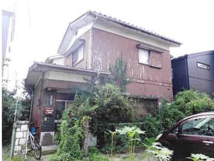
① 物件 4 建物北側の状況
