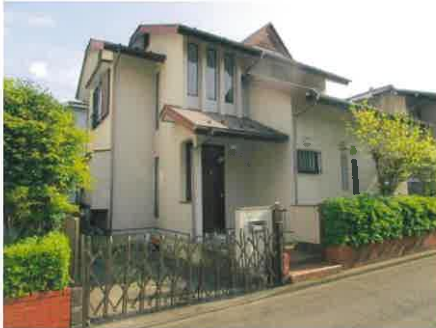
① 建物の外観
