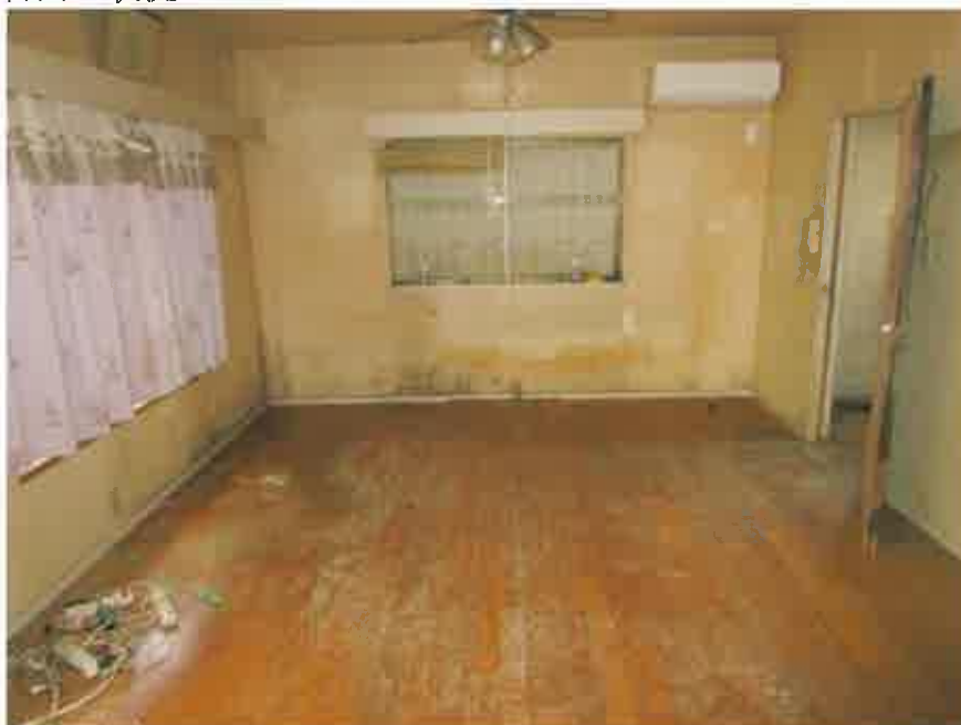
② 建物内の状況
