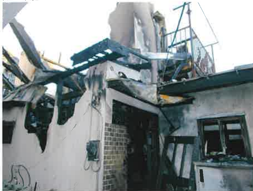
① 建物の外観
