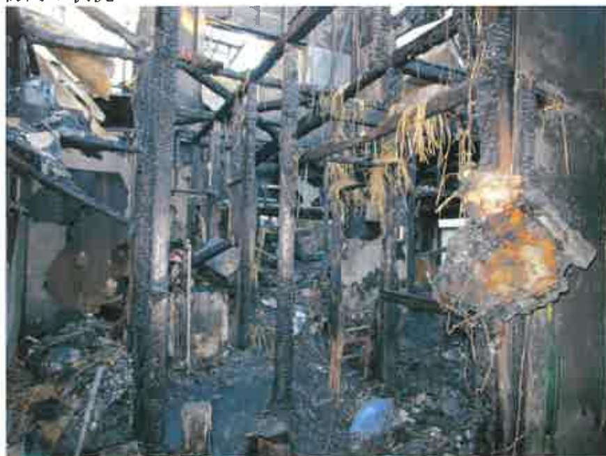
② 建物内の状況
