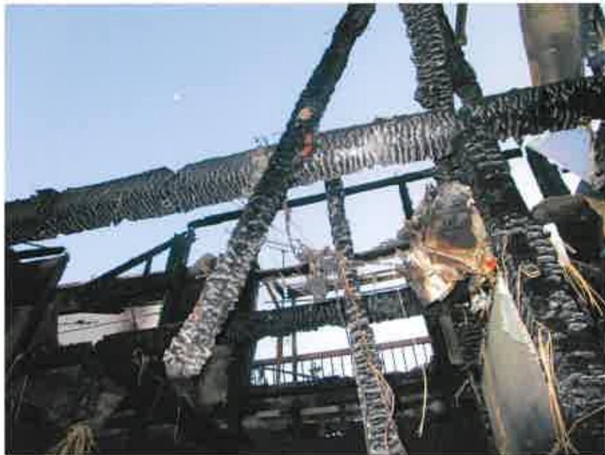
③ 建物内の状況
