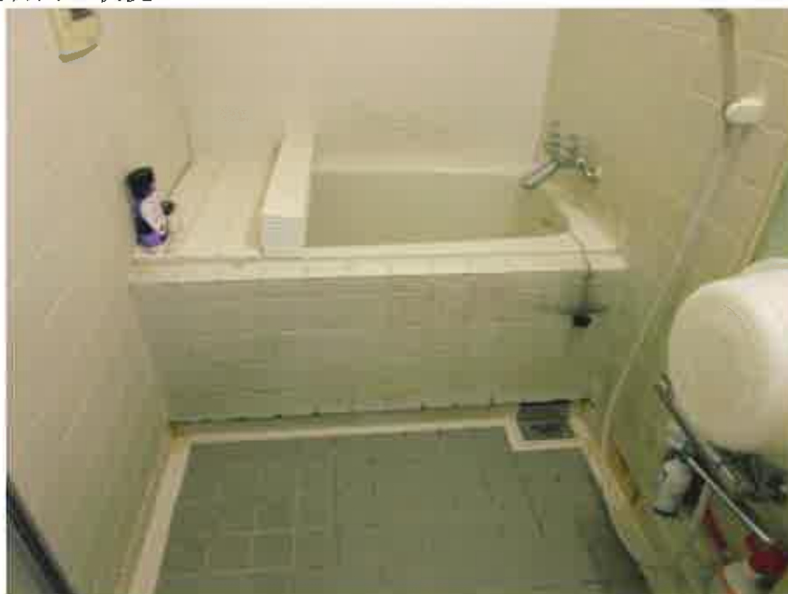
④ 建物内の状況
