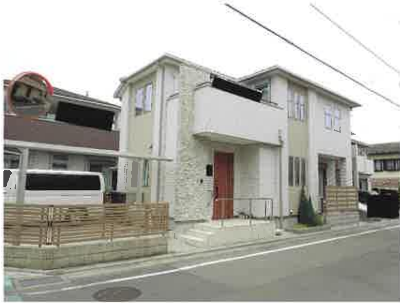
① 目的物件南西側の状況
