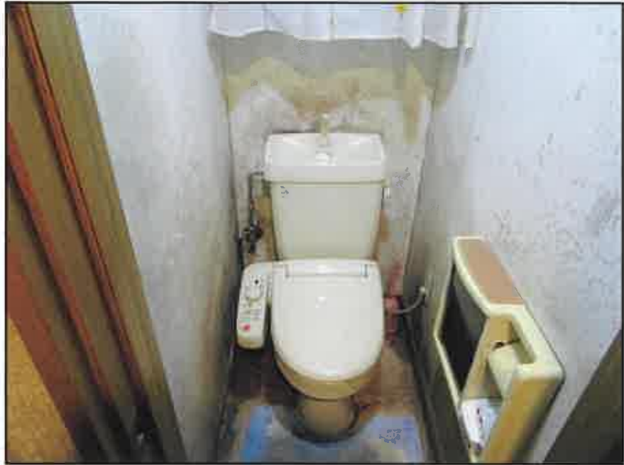
⑤ 建物内の状況ートイレ(1階)
