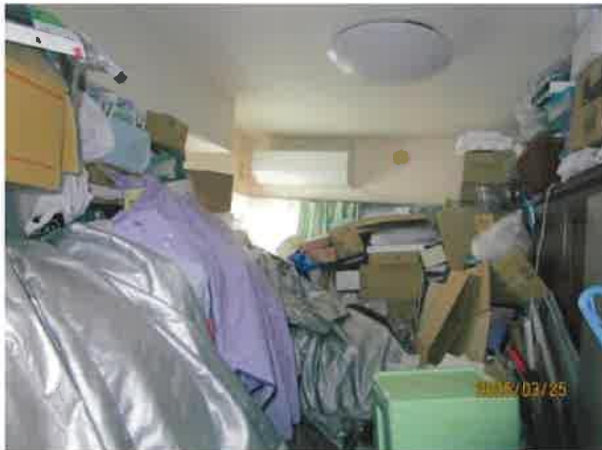
② 建物内の状況
