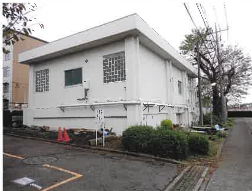
⑩ 物件 2 附属建物、符号 2 汚水処理場、北西側の状況
