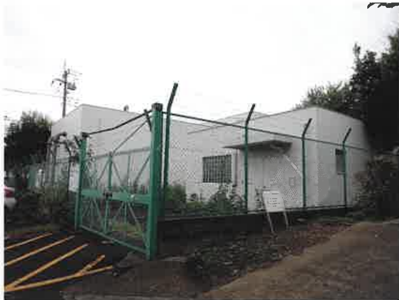
⑨ 物件 2 附属建物、符号 1 ポンプ室、南側の状況
