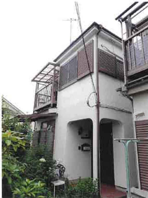
① 目的物件南東側の状況
