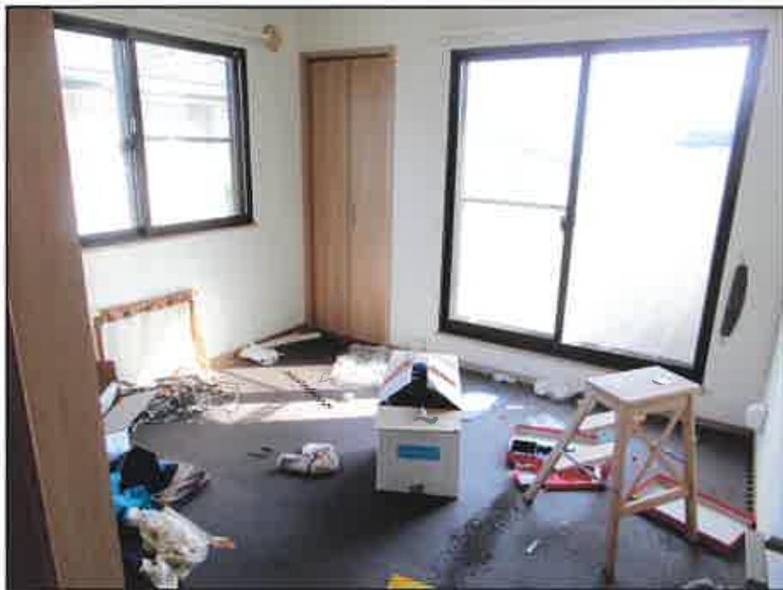
⑤ 建物内の状況－洋室3(2階)
