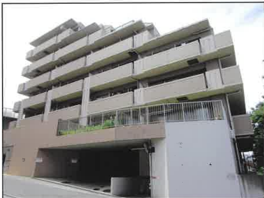
① 一棟の建物の外観
