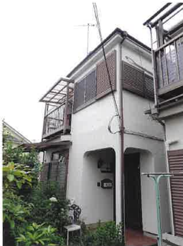
① 目的物件南東側の状況
