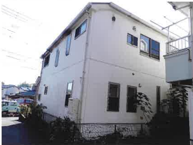
③ 目的物件北側の状況
