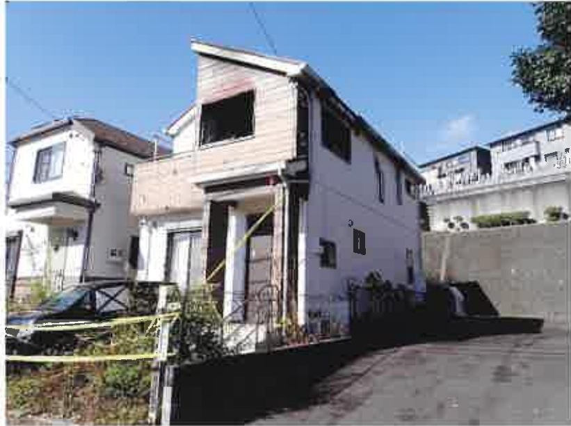
① 目的物件東側の状況
