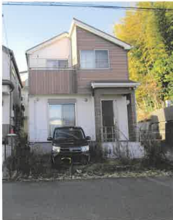
① 建物の外観
