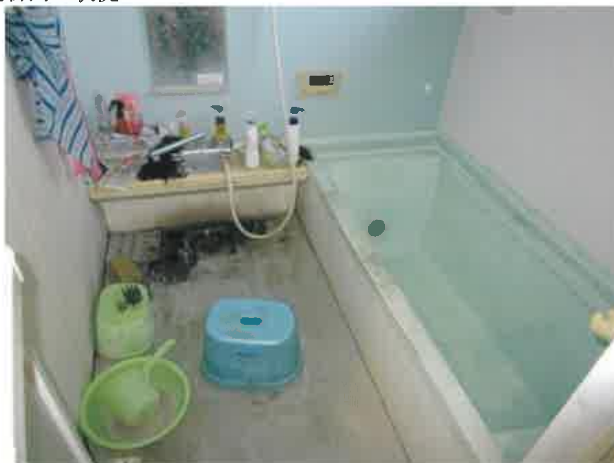
④ 建物内の状況
