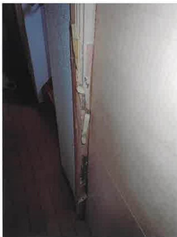
⑥ ドア枠損傷の状況
