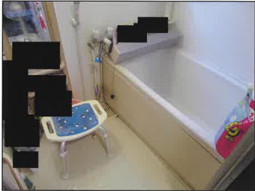
⑬ 建物内の状況－202号室:浴室
