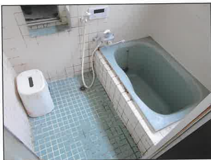
④ 建物内の状況ー浴室(1階)
