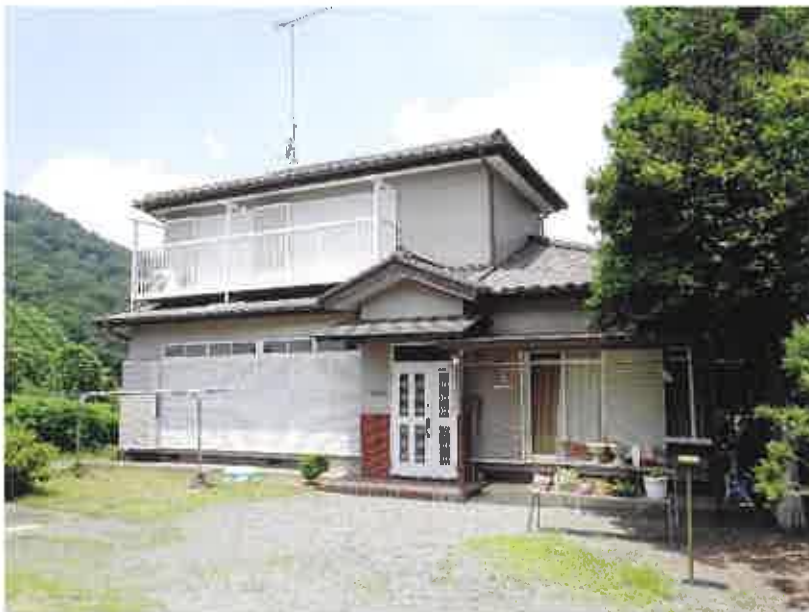
① 物件 3 建物南東側の状況
