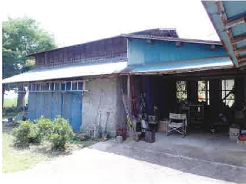
⑦ 物件 3 附属建物符号 1 北西側の状況
