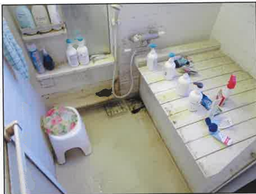
③ 建物内の状況－浴室(1階)
