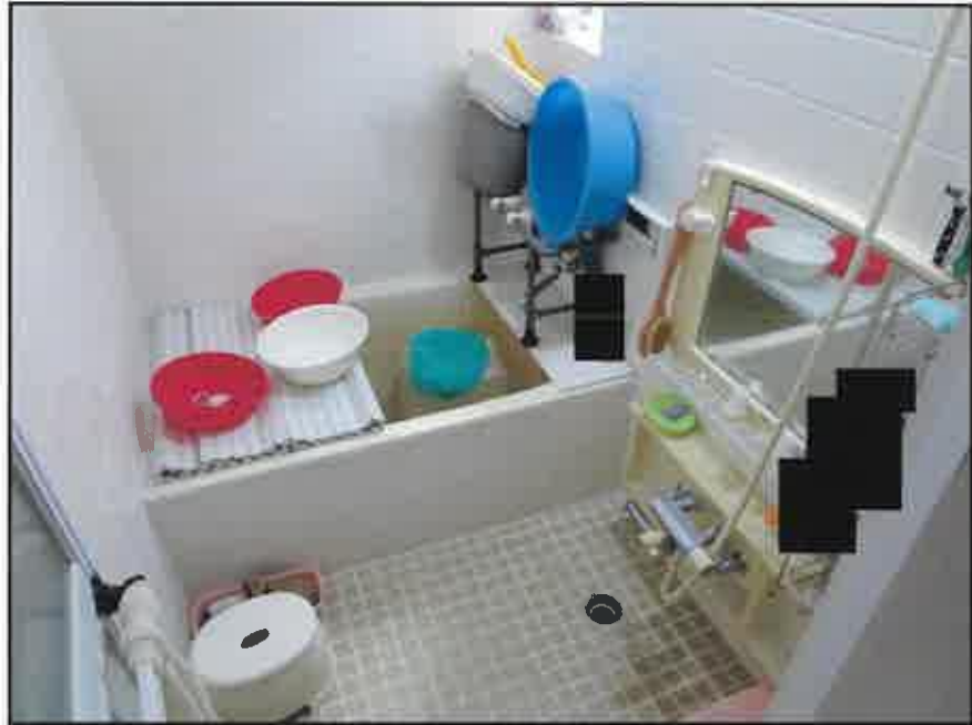
③ 建物内の状況－浴室(1階)
