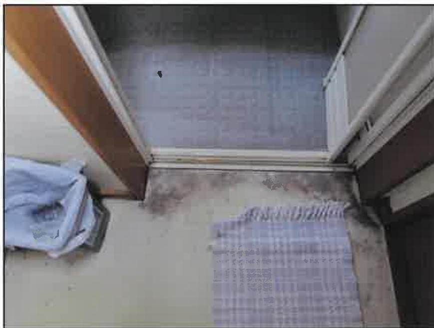
⑦ 建物内の状況—洗面所の床面(1階)
