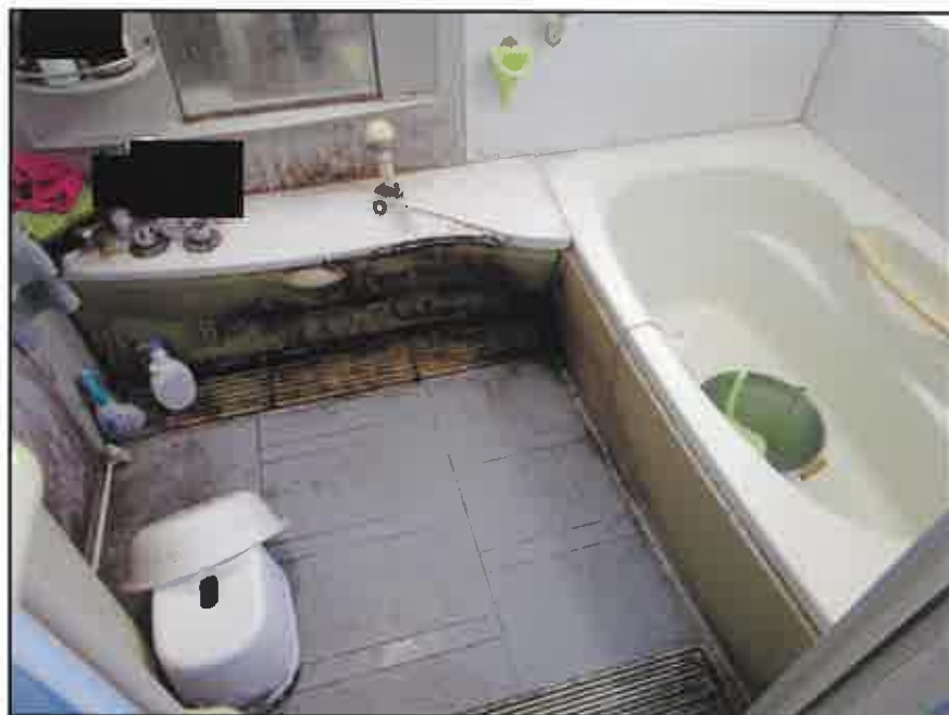
④ 建物内の状況－浴室(1階)
