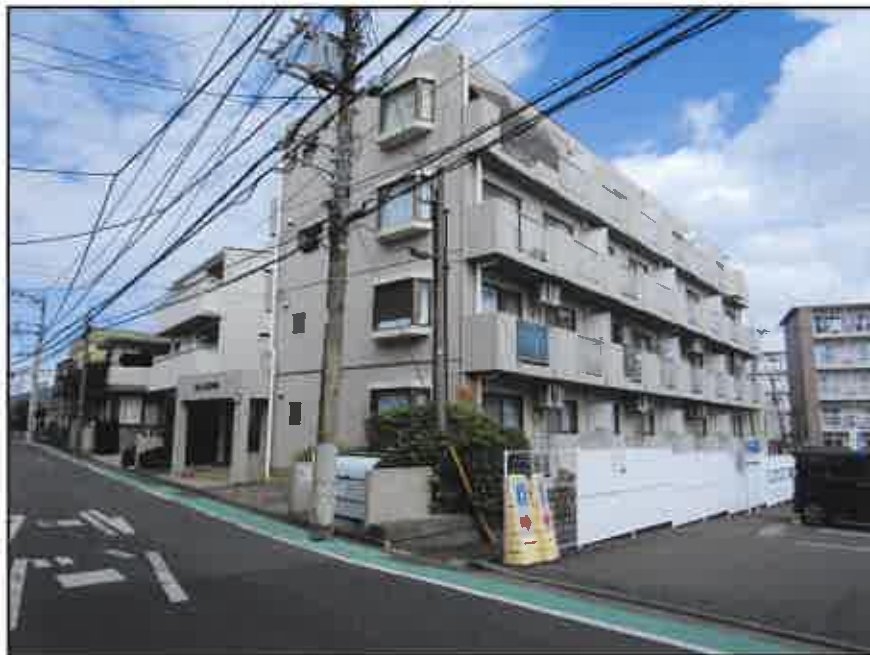
① 一棟の建物の外観
