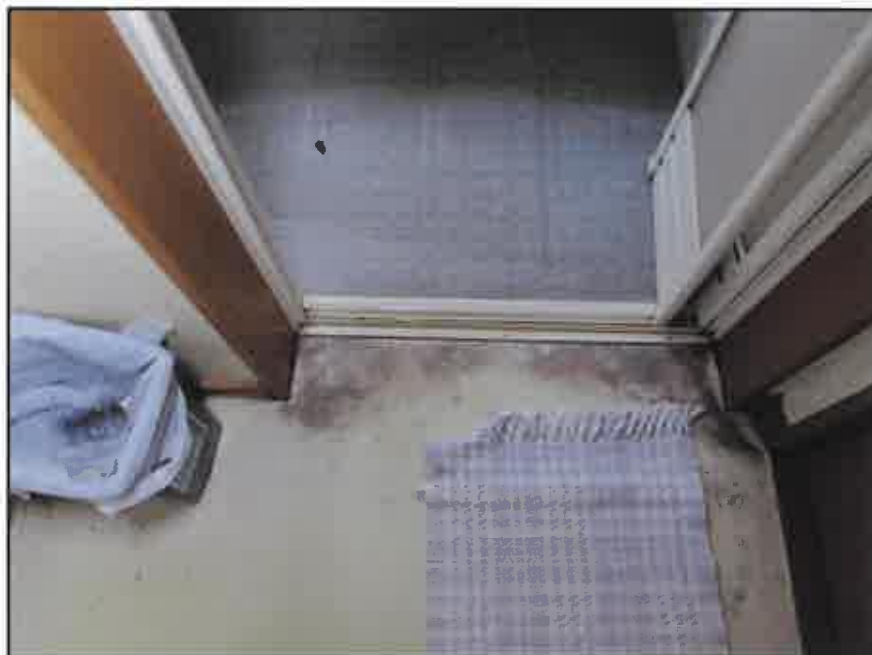
⑦ 建物内の状況－洗面所の床面(1階)
