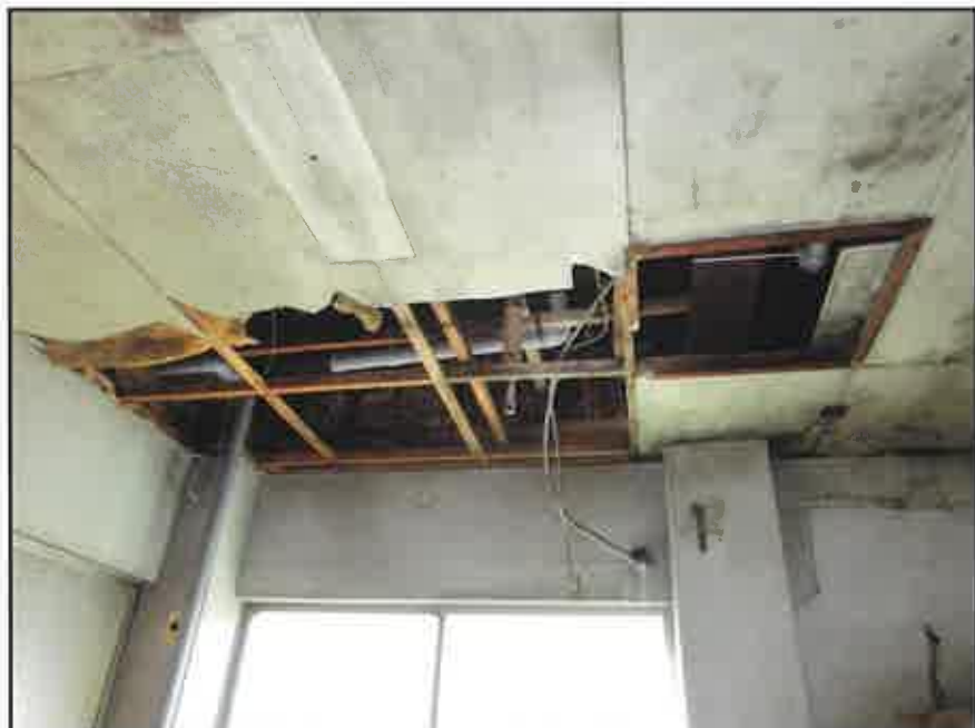
④ 建物内の状況－物置(元洗濯場):天井部分(1階)
