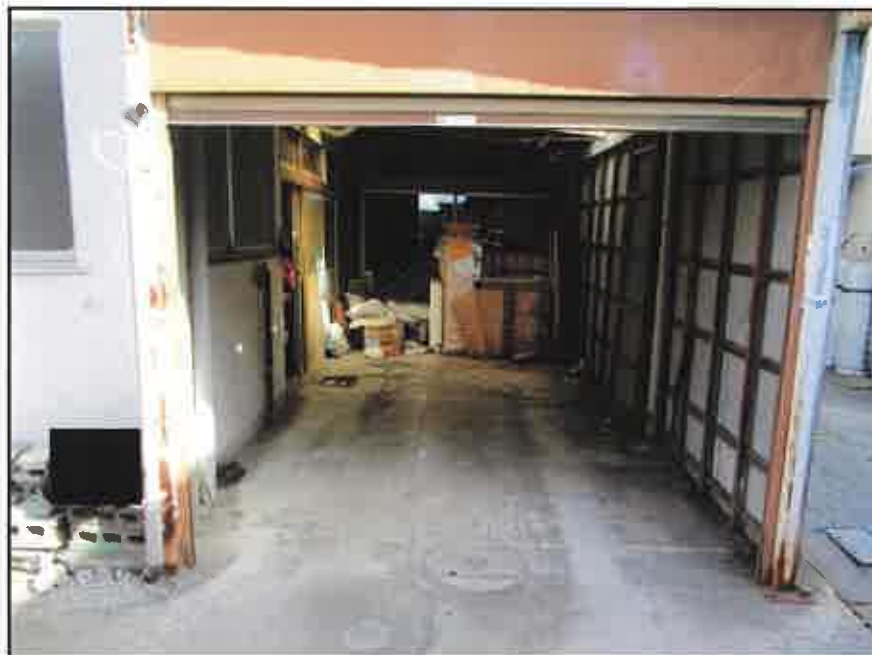
⑤ 建物内の状況－車庫(1階)
