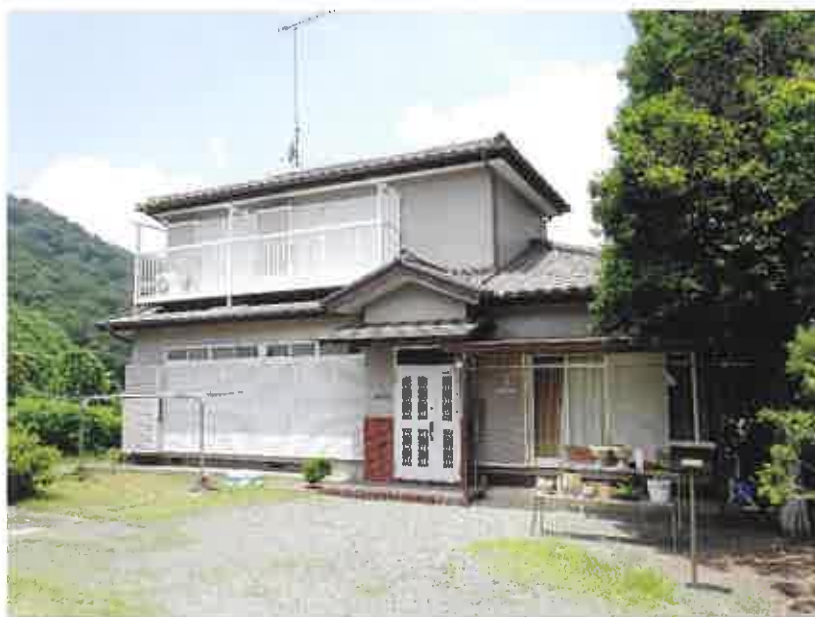
① 物件 3 建物南東側の状況
