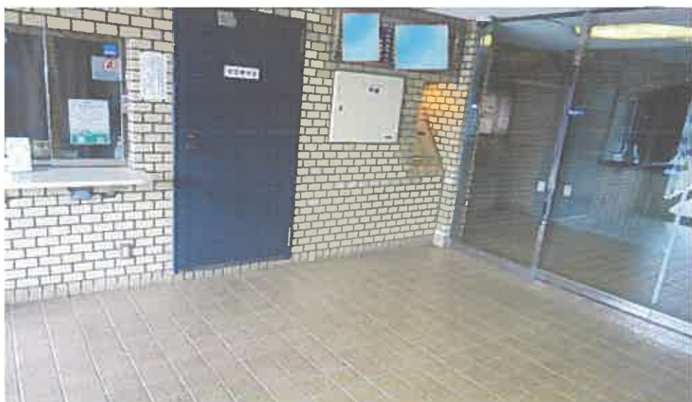
② 1階エントラ ンスホールの 状況
