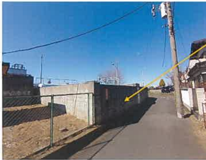
簡易ガス施設塀
