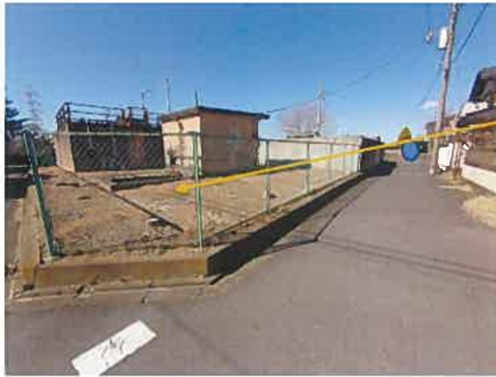
汚水処理場跡付近
