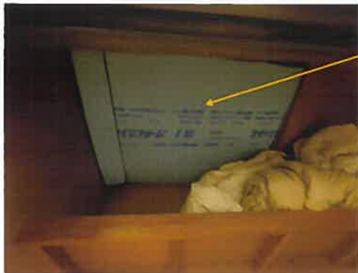
白のボードでの 天井簡易補修
