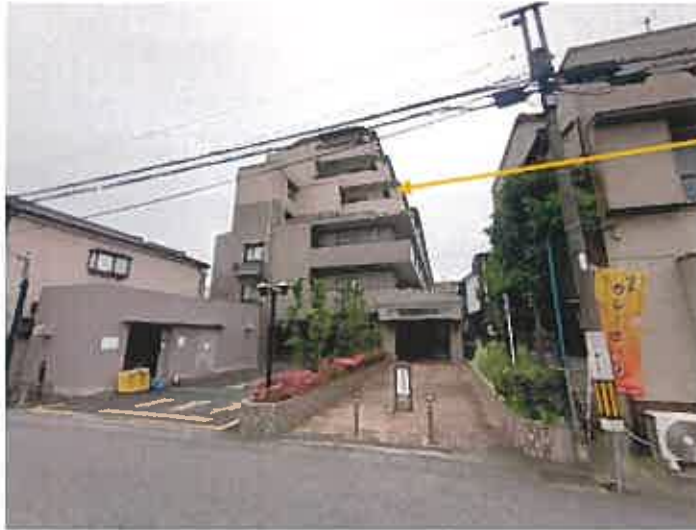
目的物件を含む 一棟の建物
