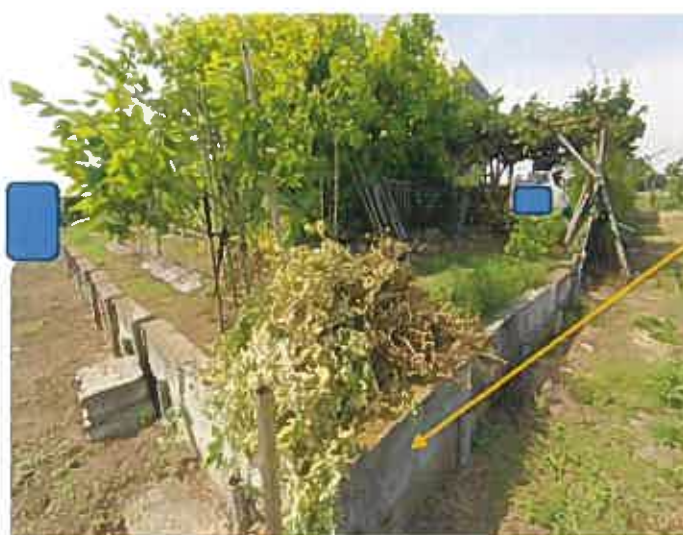
物件1南側の 大谷石による擁壁
