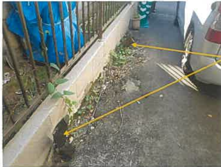
カーポート 支柱跡
