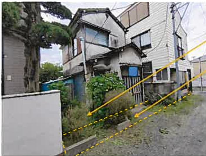
目的土地付近
