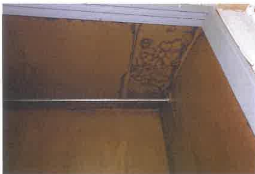
和室(4.5畳)の押入れの上部
