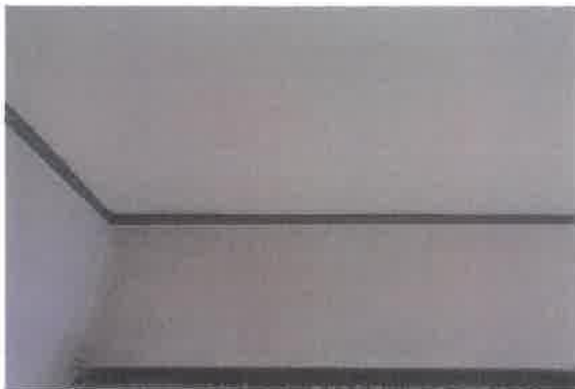
南東側和室天井及び壁の状態
