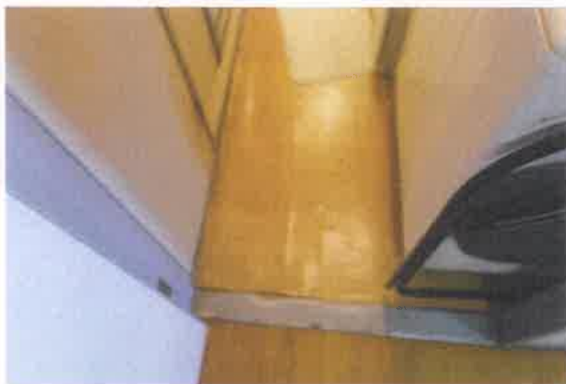
洗面脱衣室の床
